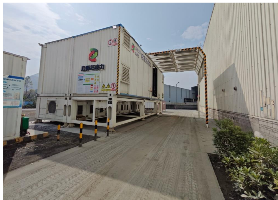
图 6-19 深莞惠试点场景 8 云浮骏鹏专用换电站实拍图
