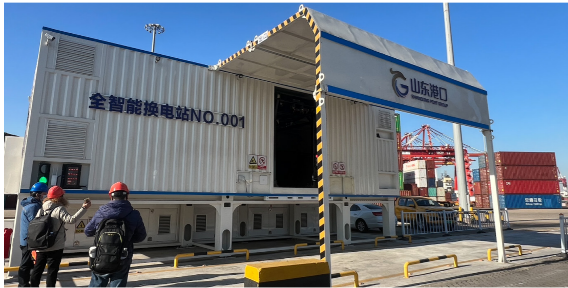
图 6-9 顶吊式换电站——前湾港四期码头 001 号站
