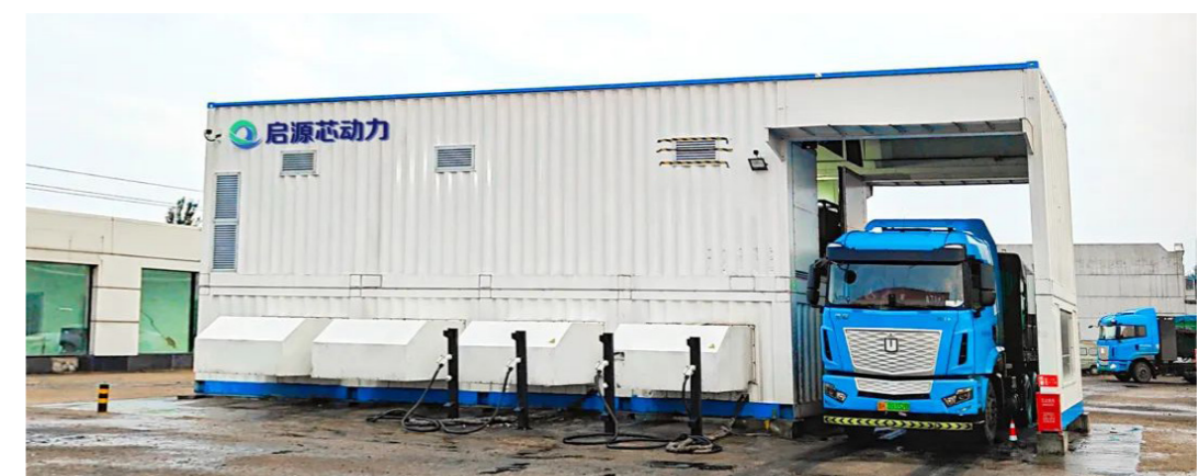
图 6-15 换电站图片 (启源芯动力提供)
